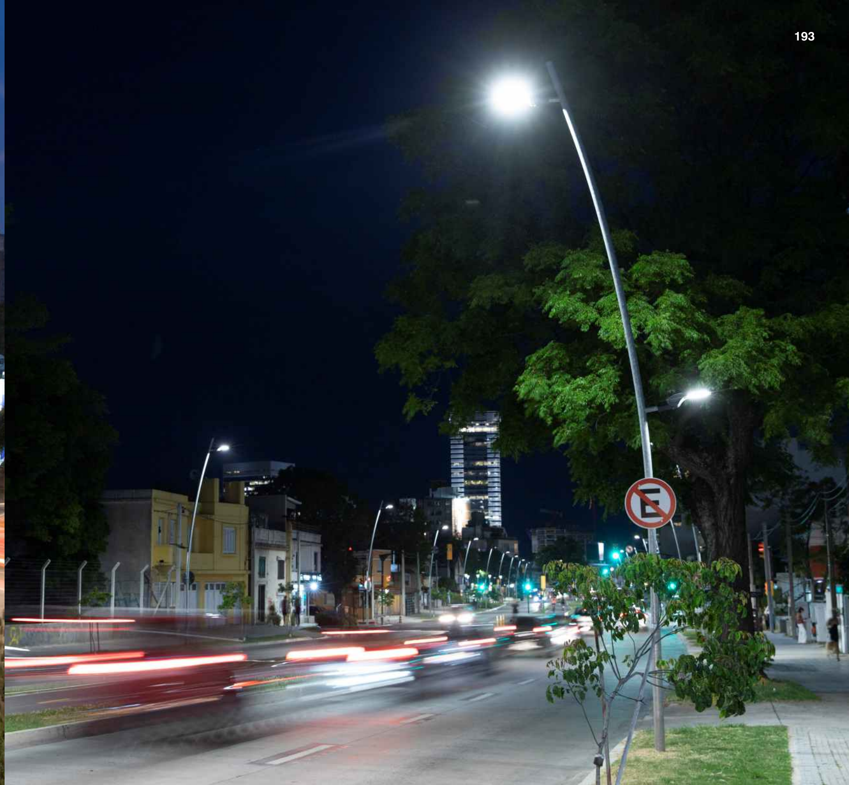
Project: Unidad Técnica de Alumbrado Público de la Intendencia de Montevideo
